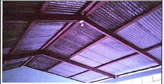
Se ve el daño que ya tiene la madera que sostiene las láminas.
